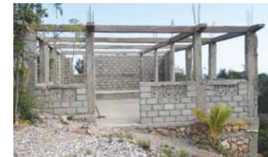
La construction de la salle polyvalente avance, il reste le toit à couler.
